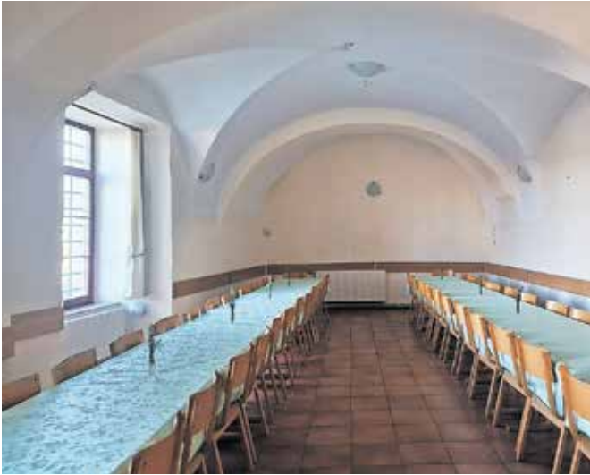
Jedilnico v Samostanu Mekinje bodo prenovili in opremili s sodobno kuhinjsko opremo. / FOTO: ARHIV OBČINE KAMNIK
