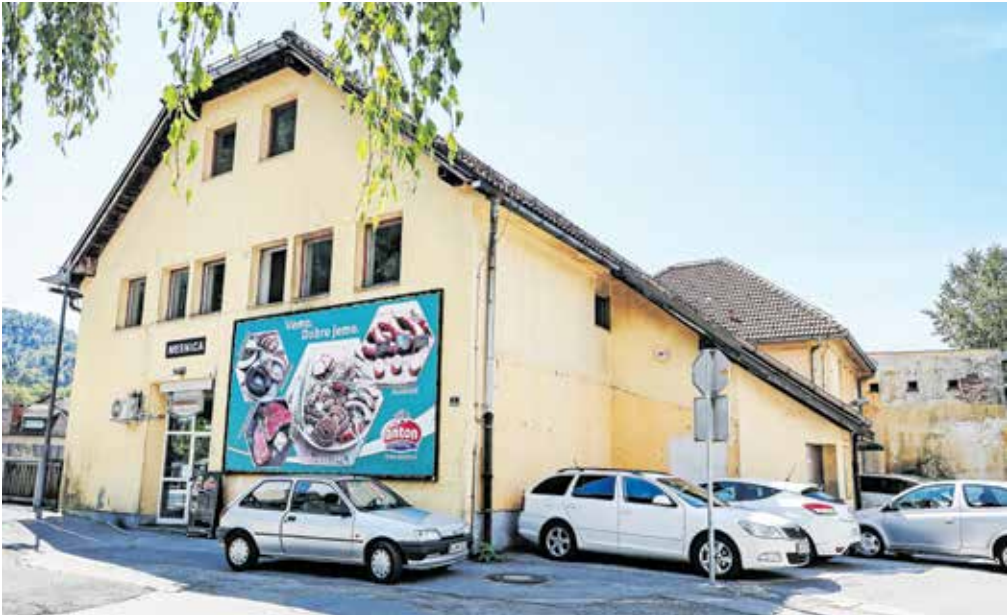
Na Usnjarski cesti 1 bo v prihodnjih letih zrasel sodoben objekt. / FOTO: TINA DOKL
